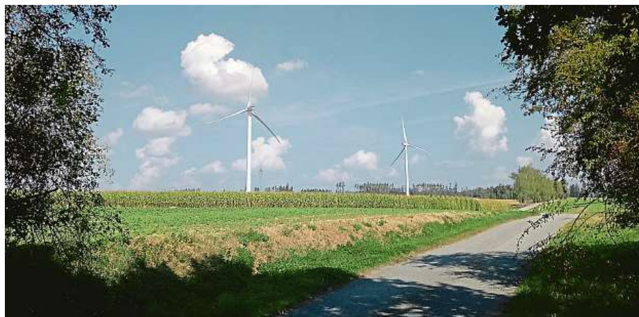
Dva velké větrníky na vršku nad obcí Věžnice na Havlíčkobrodsku vyrábějí elektřinu už patnáct let. Obec se nachází v ideálním větrném koridoru, dní bez větru je tu přes rok minimálně.
