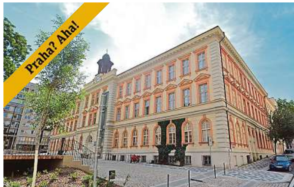
Neorenesanční budova základní školy se měla podle rozhodování poroučet k zemi, stejně jako zbytek starého Žižkova. GOOGLEMAPS
