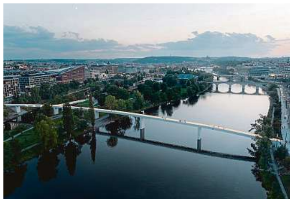
Štvanickou lávku Praha otevřela v červenci. Minulý týden byla odborníky nominována na Stavbu roku 2023. ALEX SHOOTS BUILDINGS
