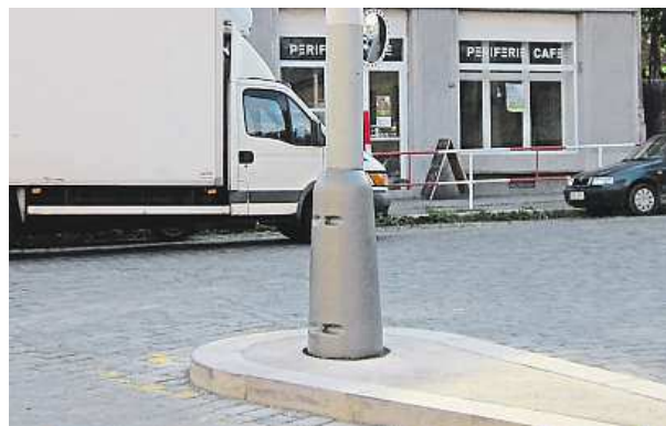
Po čtrnácti dnech byla patice sloupu opravena.
