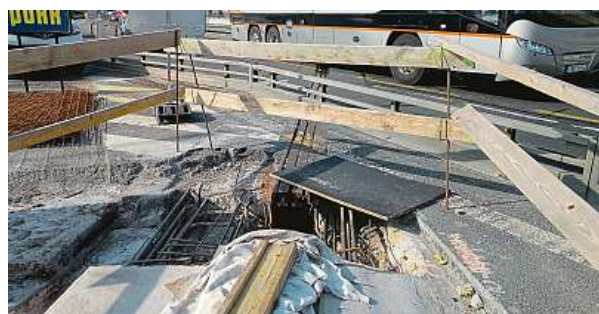
Staré a nové sřazení částí mostu. Do nového už nebude zatékat.
