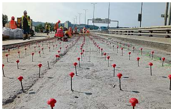
Navrnané železné tyče s krycími „bezpečnostními“ kuličkami. Tyče se posléze svaří s armaturou a tím se propojí starý a nový beton.
