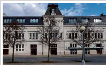
Multifunkční budova, Brno
