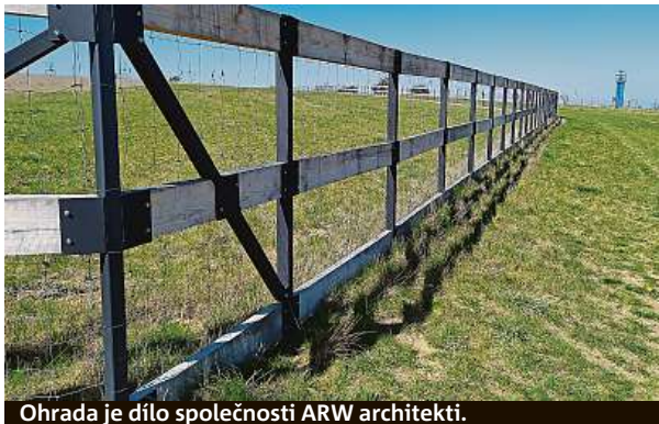
Ohrada je dílo společnosti ARW architekti.
