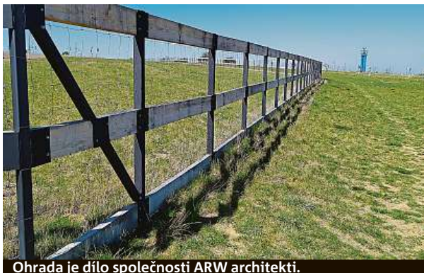
Ohrada je dílo společnosti ARW architekti.
