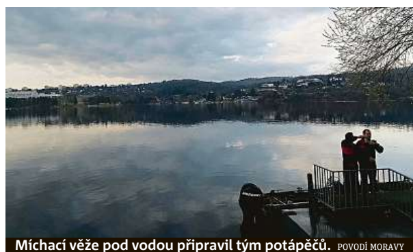
Míchací věže pod vodou připravil tým potápěčů. POVODÍ MORAVY
