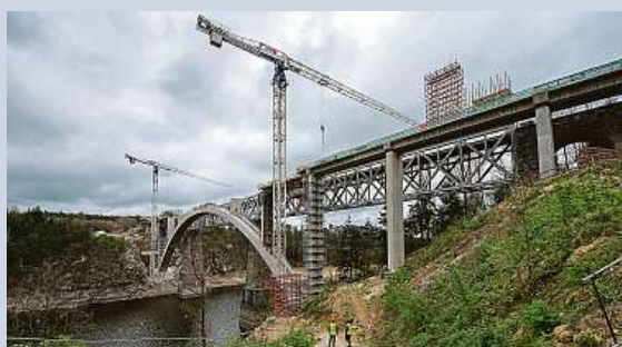
Nový obloukový železniční most na Písecku
