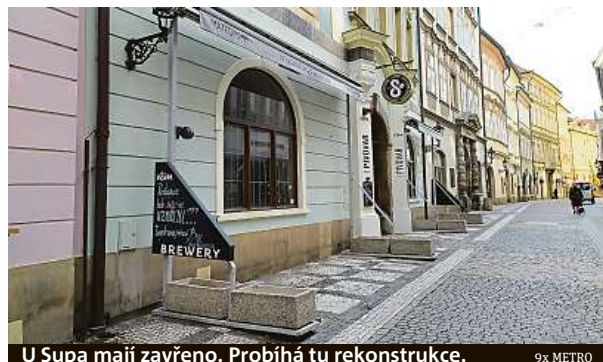
U Supa mají zavřeno. Probíhá tu rekonstrukce.
