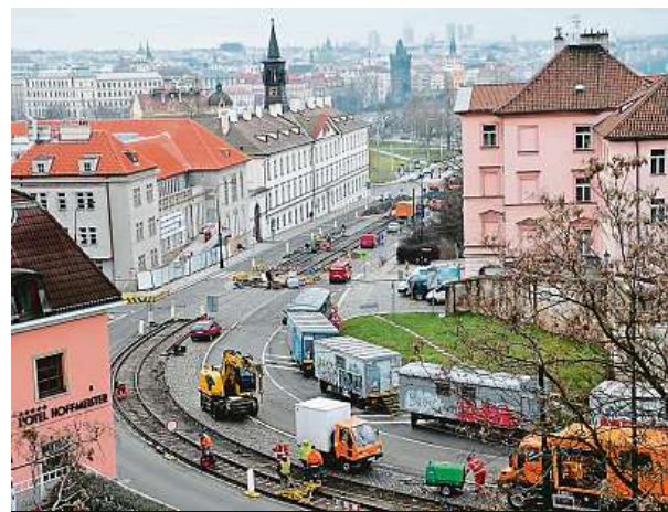
Trať v Chotkově ulici potřebovala opravit.
