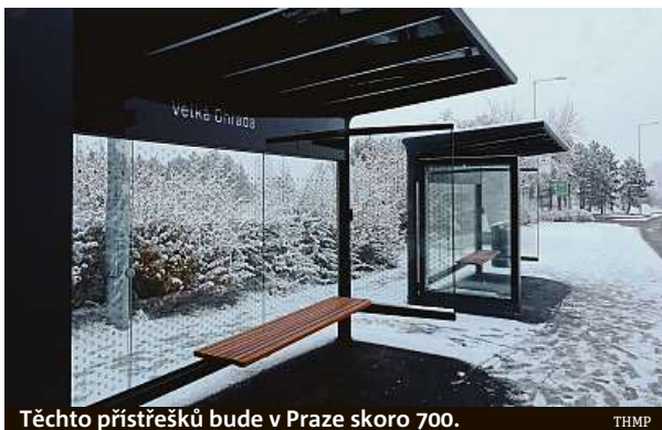
Těchto přístřešků bude v Praze skoro 700. THMP
