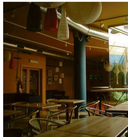
Pozn.: Viditelným důkazem instalace větrání může být pro klienta potrubí.
