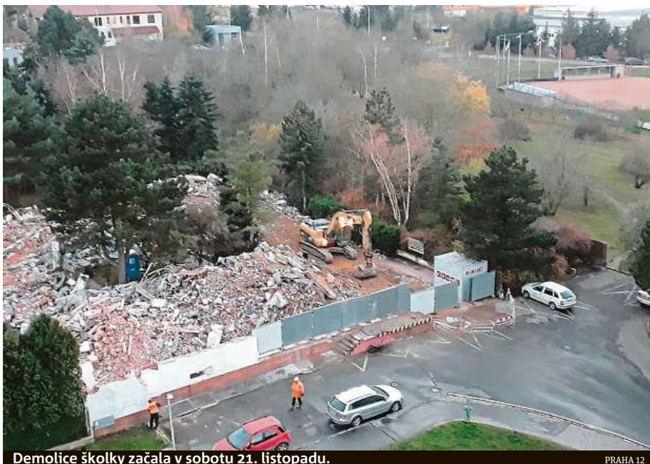
Demolice školky začala v sobotu 21. listopadu.
