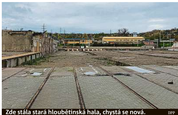
Zde stála stará hloubětínská hala, chystá se nová.
