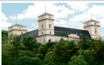
Zámek Račice, přestavba
