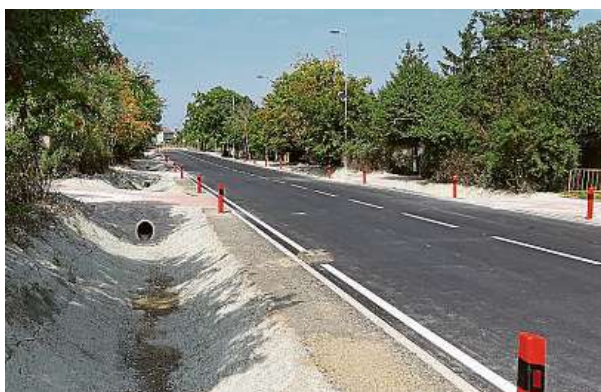
Vídeňská ulice je rovněž opravená.
