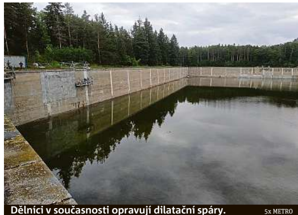
Dělníci v současnosti opravují dilatační spáry.
