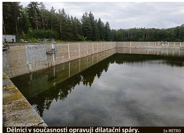
Dělníci v současnosti opravují dilatační spáry.
