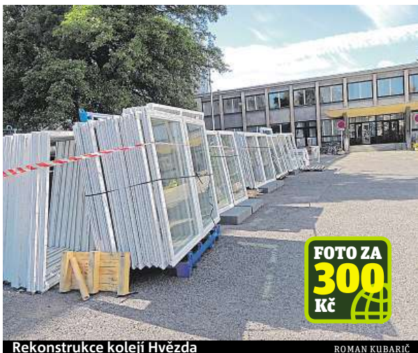
Rekonstrukce kolejí Hvězda
