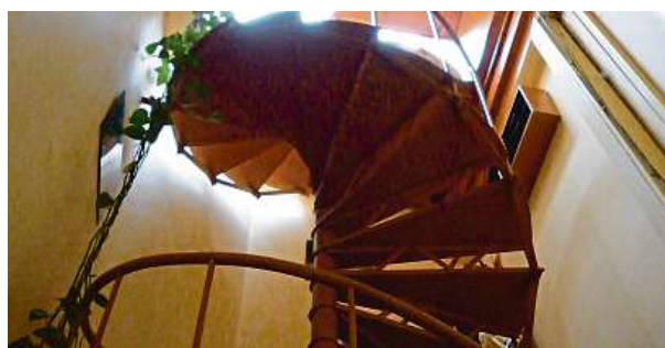
Točité schodiště na terasu meteorologické stanice Na Karlově...
