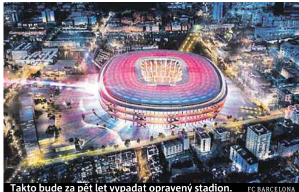
Takto bude za pět let vypadat opravený stadion. FC BARCELONA
