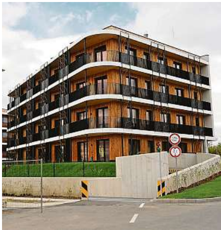
Modulární dřevostavba. Základ bytovky smontují v Rakousku, pak sestaví v Praze. METRO
