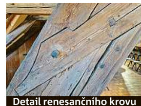
Detail renesančního krovu
