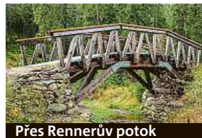
Přes Rennerův potok
