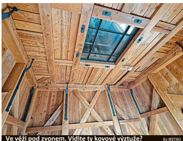
Ve věži pod zvonom. Vidíte ty kovové výztuže?
