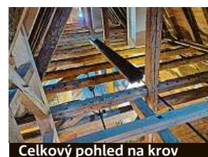
Celkový pohled na krov
