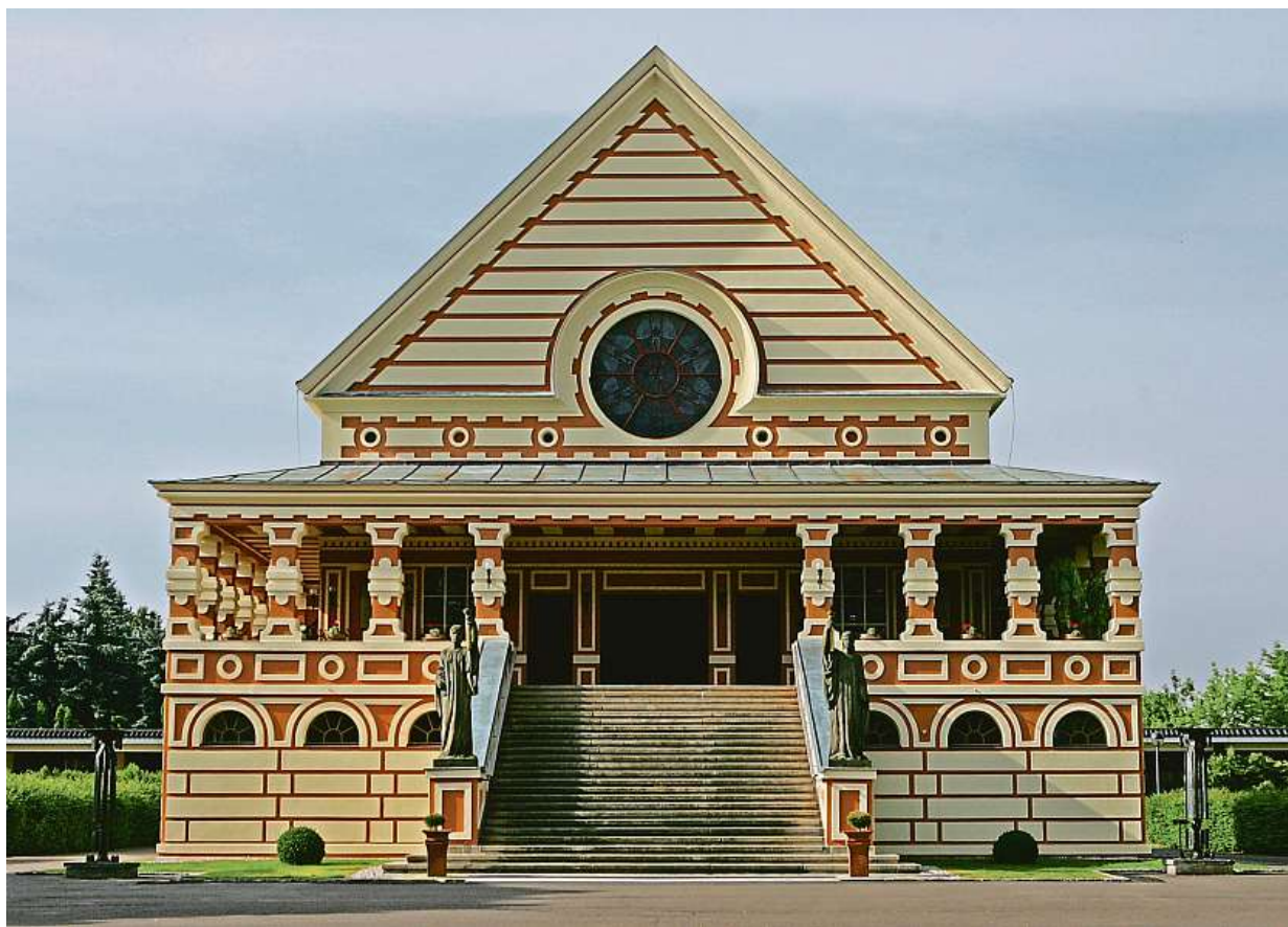
Pardubické krematorium bylo postaveno podle plánů architekta Pavla Janáka v letech 1921–1923 na jižní straně tehdejší periferie města Pardubic ve stylu art deco za podpory členů Společnosti přátel žehu.
