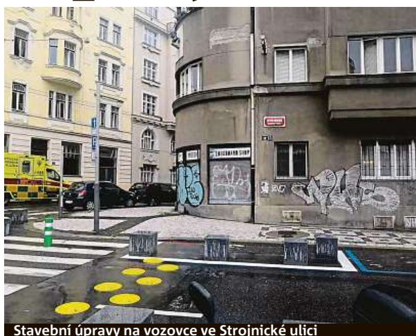
Stavební úpravy na vozovce ve Strojnické ulici
