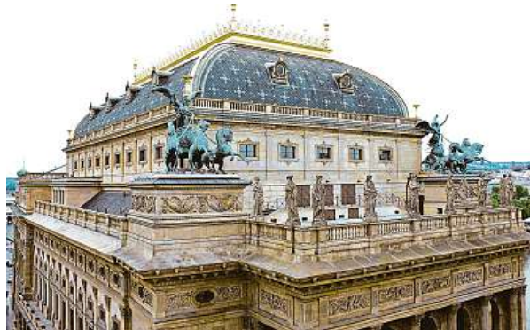
Národní divadlo kupodivu i přes své stáří na tom není energeticky úplně špatně. Navíc si vyrábí vlastní solární energii. ND
