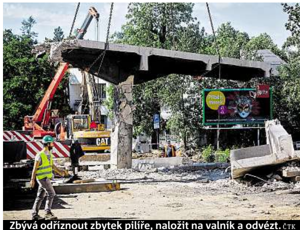
Zbývá odříznout zbytek pilíře, naložit na valník a odvézt. ČTK
