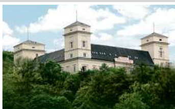
Zámek Račice, přestavba
