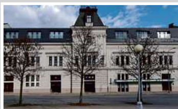
Multifunkční budova, Brno
