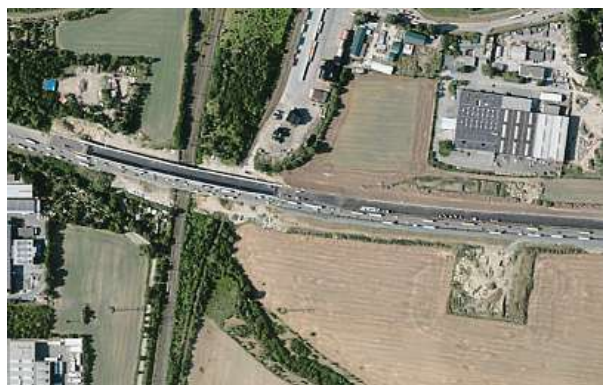
V Brně jsou na fotomape viditelné například práce na rozšiřování dálnice D1 mezi sjezdy na Vídeň a Bratislavu.
