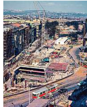
Stanicí Muzeum během stavby v roce 1973 METROSTAV
