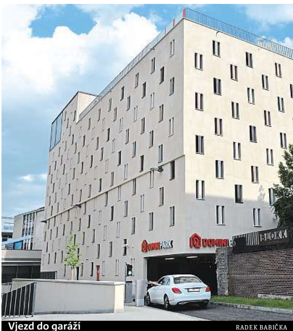
Vjezd do garáže
