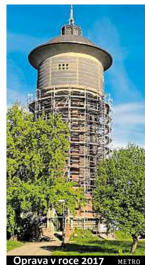
Oprava v roce 2017 METRO
