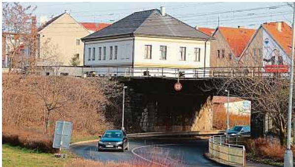
Vlevo železniční most v Karlické ulici v Praze-Radotíně nyní, vpravo vizualizace, jak by měl vypadat po rekonstrukci. 2x SŽDC
