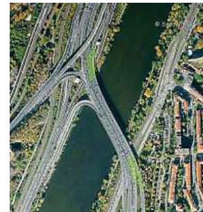
Na Barrandáku započnou i odvrtý vozovkového souvrství.
