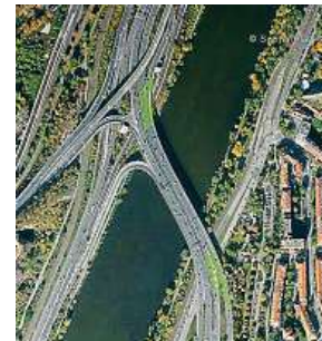
Na Barrandáku započnou i odvrtý vozovkového souvrství.
