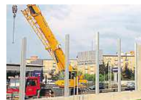
Montáž první stěny TSK
