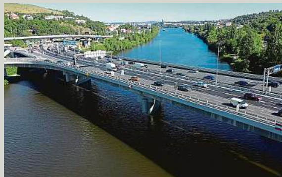
Práce na horní části mostu skončily letos v září. Dokončovací práce pak pokračovaly pod konstrukcí a na březích Vltavy. TSK
