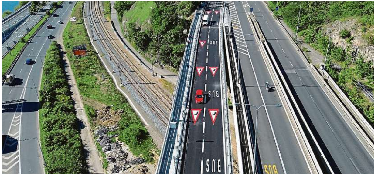
V půlce září skončily veškeré práce omezující dopravní provoz na Barrandovském mostě, a to včetně dopravních omezení na jeho předpolích. Harmonogram prací na příští rok se bude řešit v lednu. Práce mají na každý pád za celé období přijít na 594 a půl milionu korun. 2x TSK
