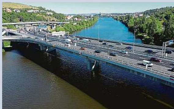
Práce na horní části mostu skončily letos v září. Dokončovací práce pak ještě pokračovaly pod konstrukcí a na březích Vltavy.
