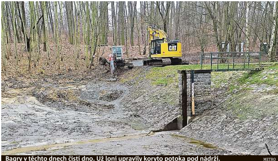
Bagry v těchto dnech čistí dno. Už loni upravily koryto potoka pod nádrží.
