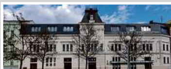
Multifunkční budova, Brno
