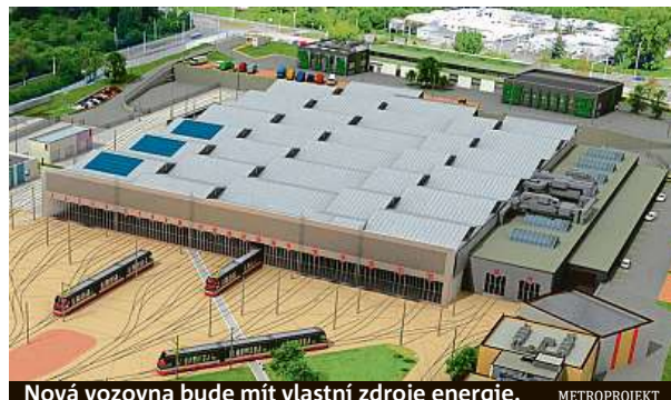
Nová vozovna bude mít vlastní zdroje energie. METROPROJEKT
