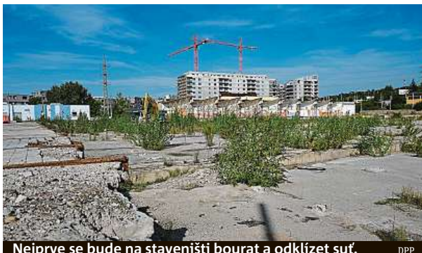
Nejprve se bude na staveništi bourat a odklízet suť. DPP
