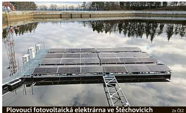
Plovoucí fotovoltaická elektrárna ve Stěchovicích 2x ČEZ
