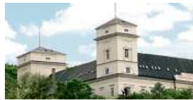
Zámek Račice, přestavba
