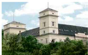
Zámek Račice, přestavba
