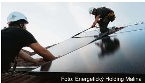
Foto: Energetický Holding Malina
