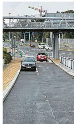
Technická správa komunikací chce práh co nejdříve upravit.
