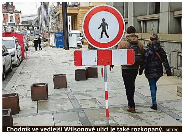
Chodník ve vedlejší Wilsonově ulici je také rozkopaný. METRO
